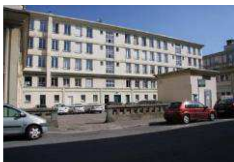
N5 Seuil balustrade béton rue d'Estimauville
