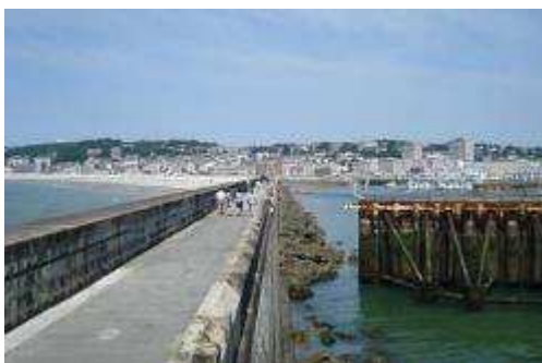
Digue Nord: Belvédère sur le centre reconstruit
